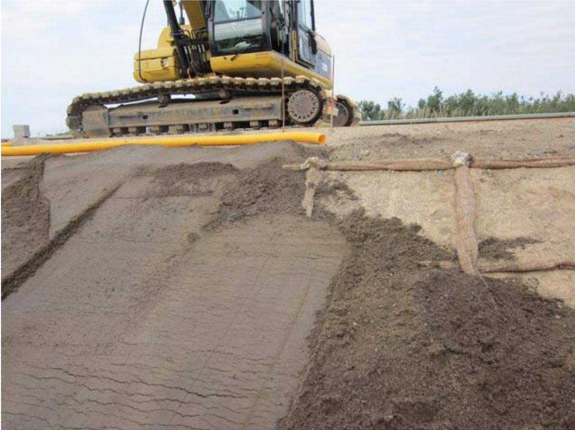
*Bild FB4.2: Einbauzustand, Befüllung mit Oberboden, Raster 1x1 m, Böschungsneigung 1:3 (Bild: S. Wiese)*
