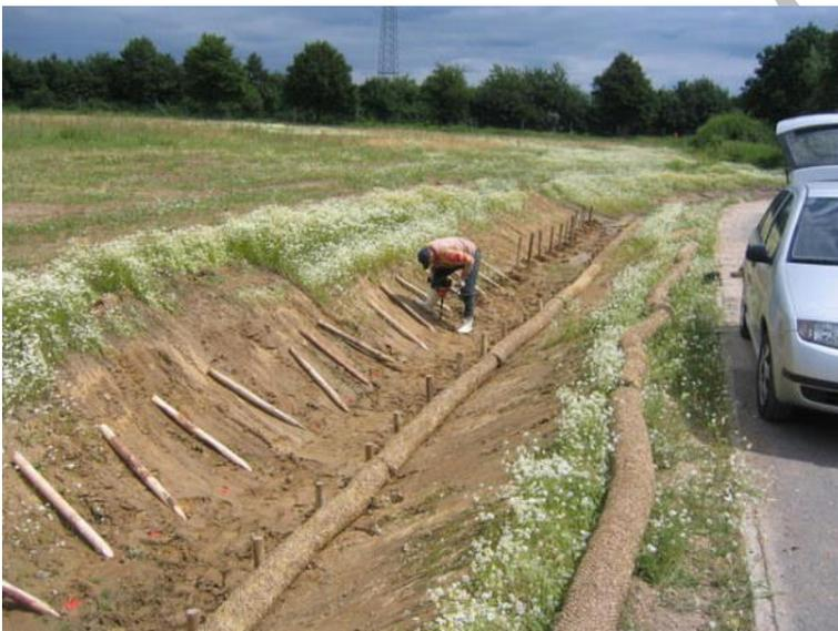
*Bild 6.23: Erosionsschutz mit Walze am Böschungsfuß – Beispiel Straßengraben, Bauzustand (Foto: S. Wiese)*
