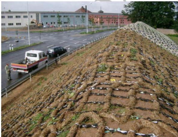
**D. Kettengewirk** aus groben walzenartigen Einzelsträngen mit KEMAFIL-Technologie, Rollenware (Foto: S. Wiese)
