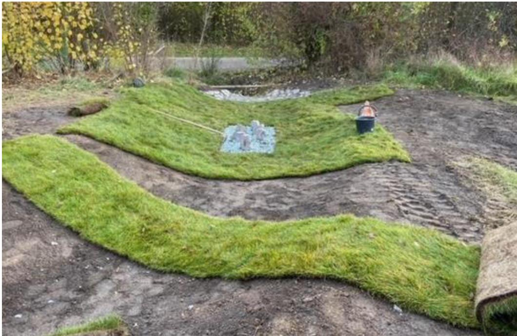
Bild 6.20: Erosionsschutz mit Vegetationsmatte in einer Mulde in Riedberg (Foto: S. Wiese)
