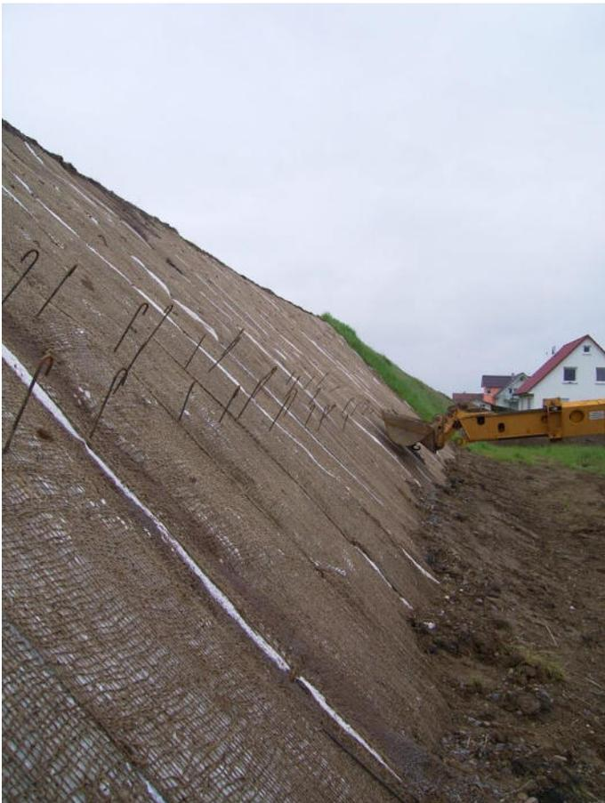
*Bild FB1.3: Einbaudetail: Begrünungsmatte und Fixierungselemente (Foto: Bott Begrünungssysteme GmbH)*
