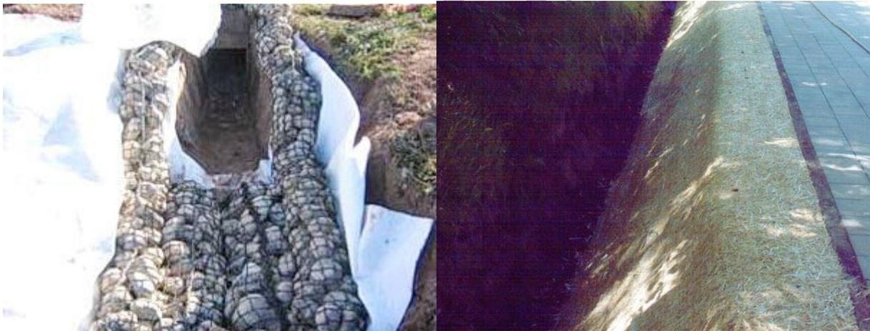
*Bild 6.25: Details: Sicherung des Einlaufbereichs mit Steinwalzen (links), Sicherung der Böschung oberhalb der Fußsicherung mit Begrünungsmatte, vgl. Flächen und Böschungen (rechts) (Fotos: S. Wiese)*
