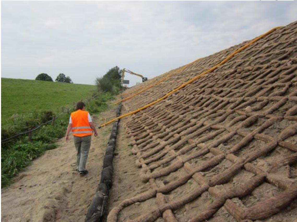
*Bild FB4.1: Einbauzustand (Böschungsfuß mit Miscanthuswalze, Böschungssicherung mit Schafwollfaschinen, gitterförmig, Raster 0,5 x 0,5 m) (Bild: S. Wiese)*
