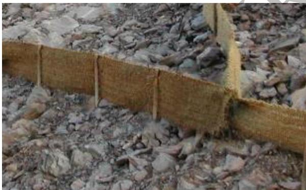
*Bild 6.9 Fixierung einer Oberbodenschicht auf einer steilen Böschung, Beispiel für Böschungsbänder, Detail (Foto: Neisser Geoprodukte GmbH)*
