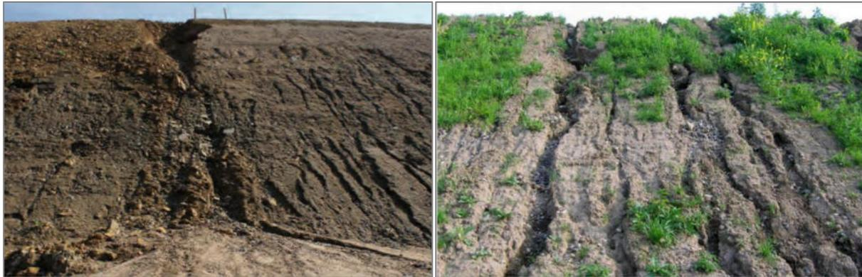
Bild 1.5 Oberflächenerosion an Böschungen (Fotos: S. Bloemer, Bender GmbH & Co. KG)
