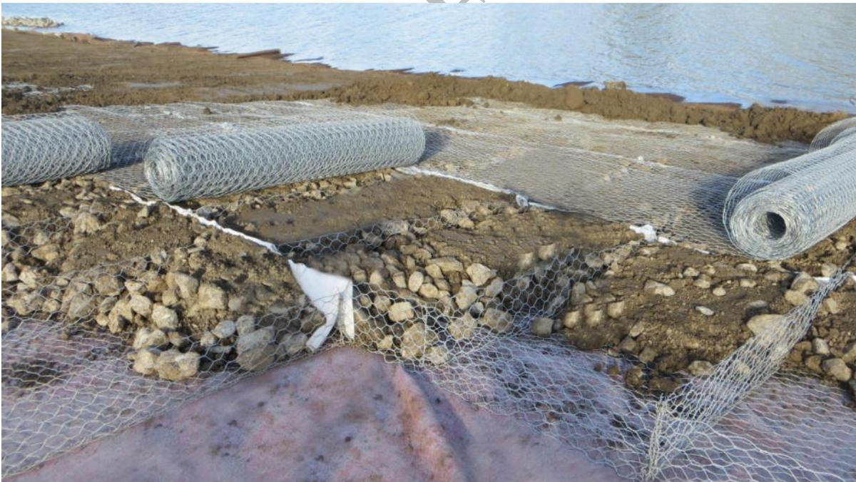
**B. Steinmatratze mit verzinkten Stahlnetzen (Foto: R. Neisser)**
