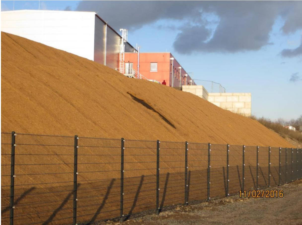
*Bild 6.1 Erosionsschutz mit Kokosmatte an einer Böschung, Beispiel für GBL (Foto: R. Neisser)*
