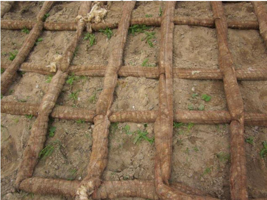
*Bild FB4.3: Detail, Fixierung, Raster 0,5 x 0,5 m (Bild: S. Wiese)*
