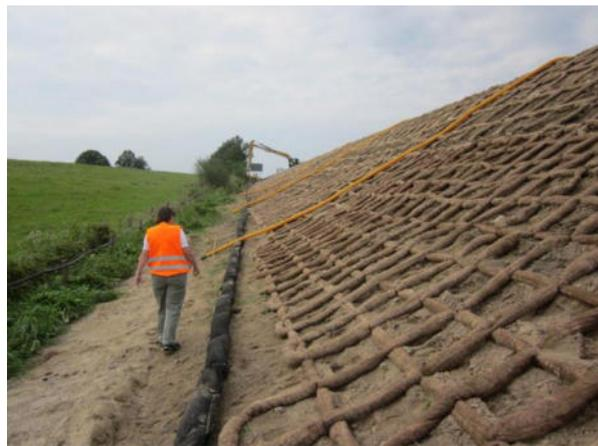
**E. Zellenartig verlegte walzenartige Schafwollfaschine** in Naturfaserschlauch (Foto: S. Wiese)
