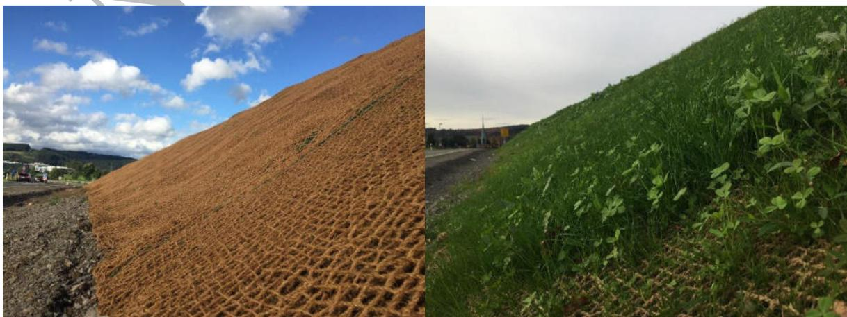
*Bild 6.7 Erosionsschutz Lärmschutzwall in Attendorn (NRW) mit Nass-Ansaat und aufgelegtem Kokosgewebe (Fotos R. Neisser)*
