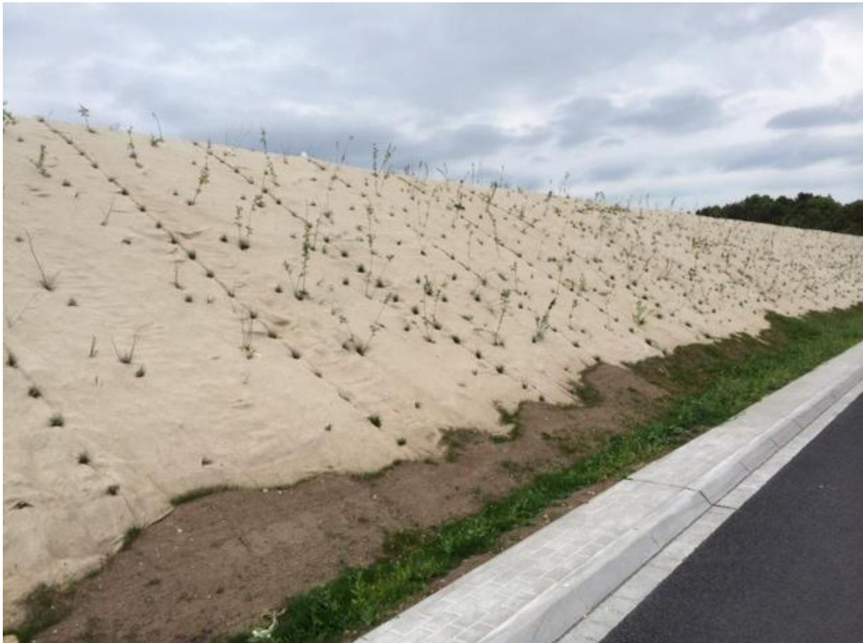
*Bild 6.6 Erosionsschutz Autobahnböschung mit Schafwoll-Vliesstoff, nachträglich mit Steckhölzern bepflanzt (Foto. S. Wiese)*
