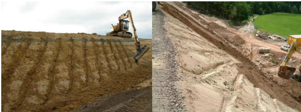
*Bild 5.1 Herstellung von Baggerriefen vor (links) und während der Andeckung mit Oberboden (rechts) (Fotos: RK Landschaftsbau Dittersdorf GmbH)*
