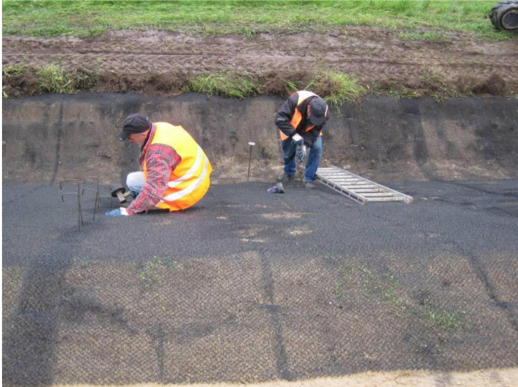
*Bild FB6.3: Detail Fixierung der GMA auf der Böschung (Foto: Colbond GmbH & Co. KG)*
