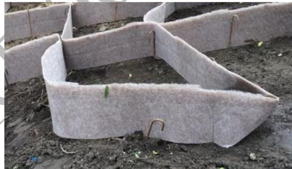
**B. Böschungsbänder** aus Schafwollvliesstoff, hier geozellenförmig eingebaut (Foto: S. Wiese)
