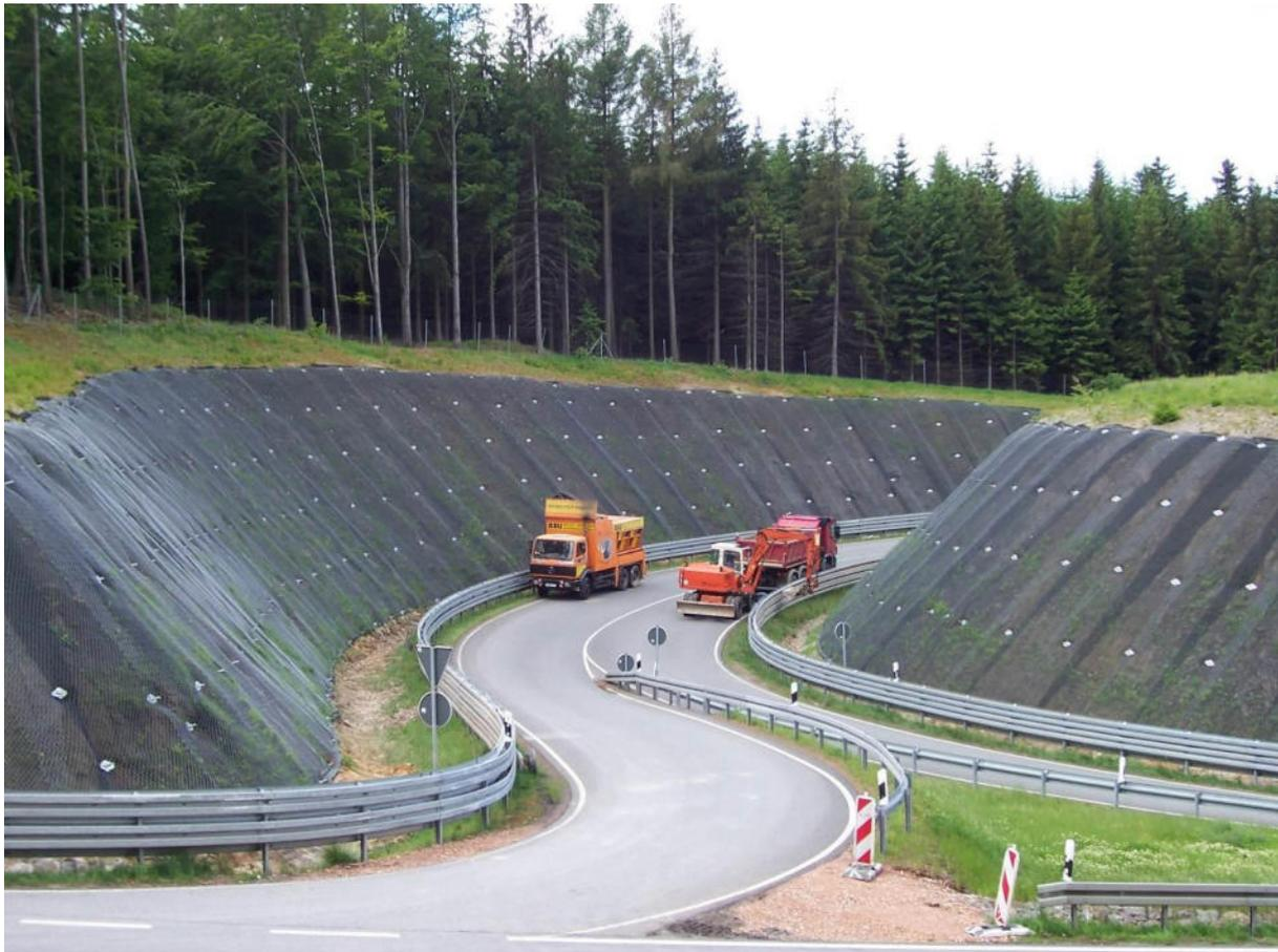
*Bild 6.4 Erosionsschutz an felsiger Anschnittböschung, Beispiel für GMA (Foto: M. Hering)*
