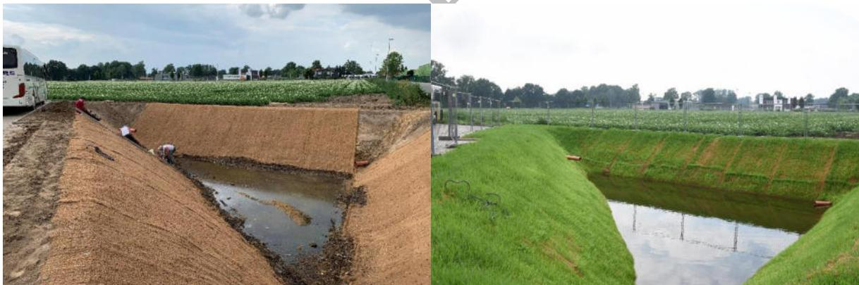
*Bild 6.19: Erosionsschutz mit Begrünungsmatte an der Böschung eines Regenrückhaltebeckens (Fotos: J. Meyer)*
