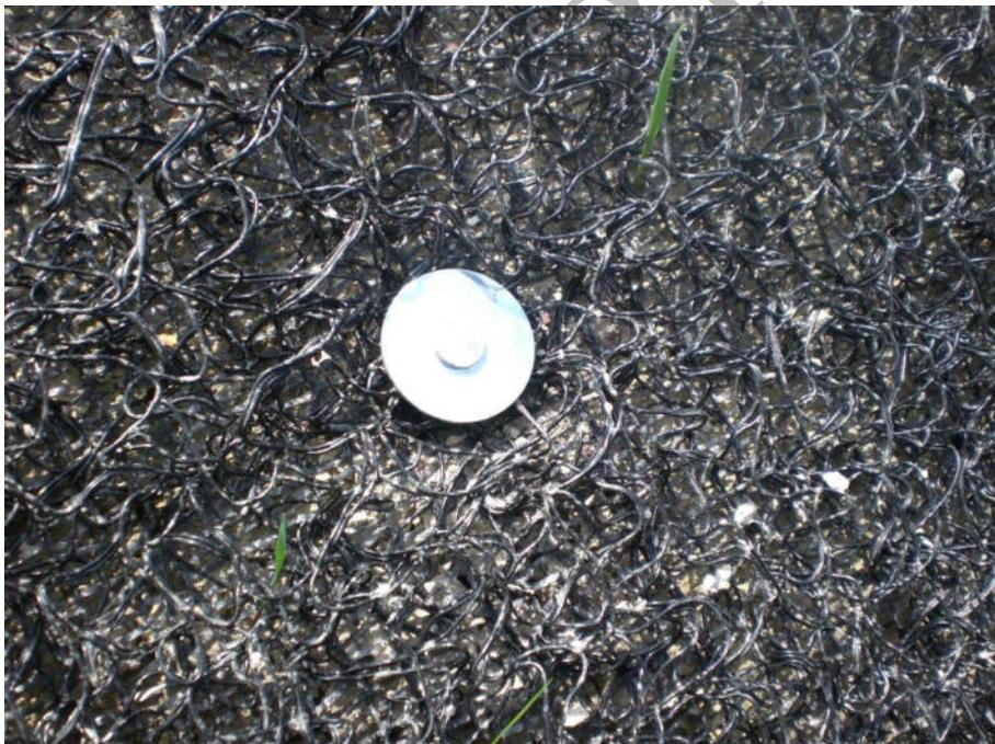
*Bild PW1.3: Secumat® an BAB A 38, Erdnagel zur Fixierung auf der Böschung (Foto: NAUE GmbH & Co. KG)*
