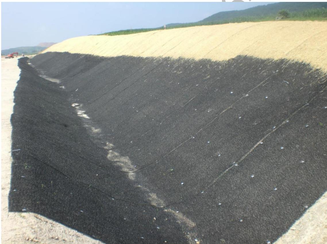
*Bild PW1.1: Secumat® an BAB A 38, Böschung Fahrtrichtung Göttingen, vor Überschüttung (Foto: NAUE GmbH & Co. KG)*
