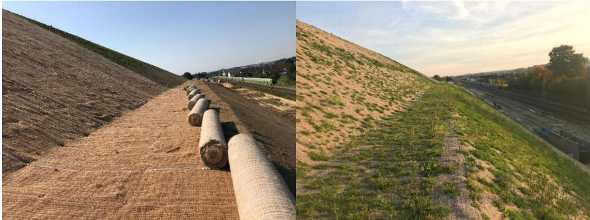
*Bild 6.3 Erosionsschutz mit Begrünungsmatte an einer Böschung, Einbausituation (links) und beginnende Vegetation (4 Wochen nach Einbau) (Foto: R. Neisser)*
