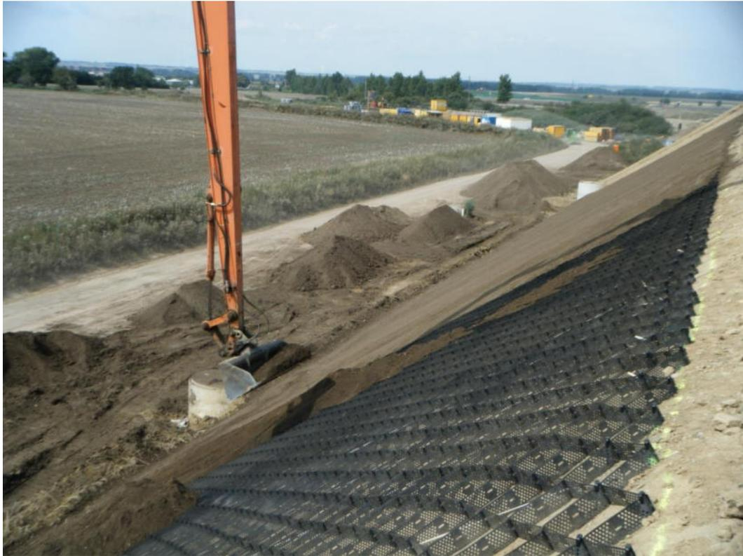
*Bild 6.12 Erosionsschutz Geozelle an Straßenböschung / Brückenwiderlager (Foto: Fa. Soiltec GmbH Achim)*
