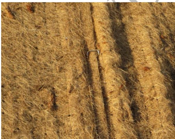
*Bild 6.2 Detail Befestigung Überlappungsbereich Kokosmatte (Fixierungselement) (Foto: R. Neisser)*
