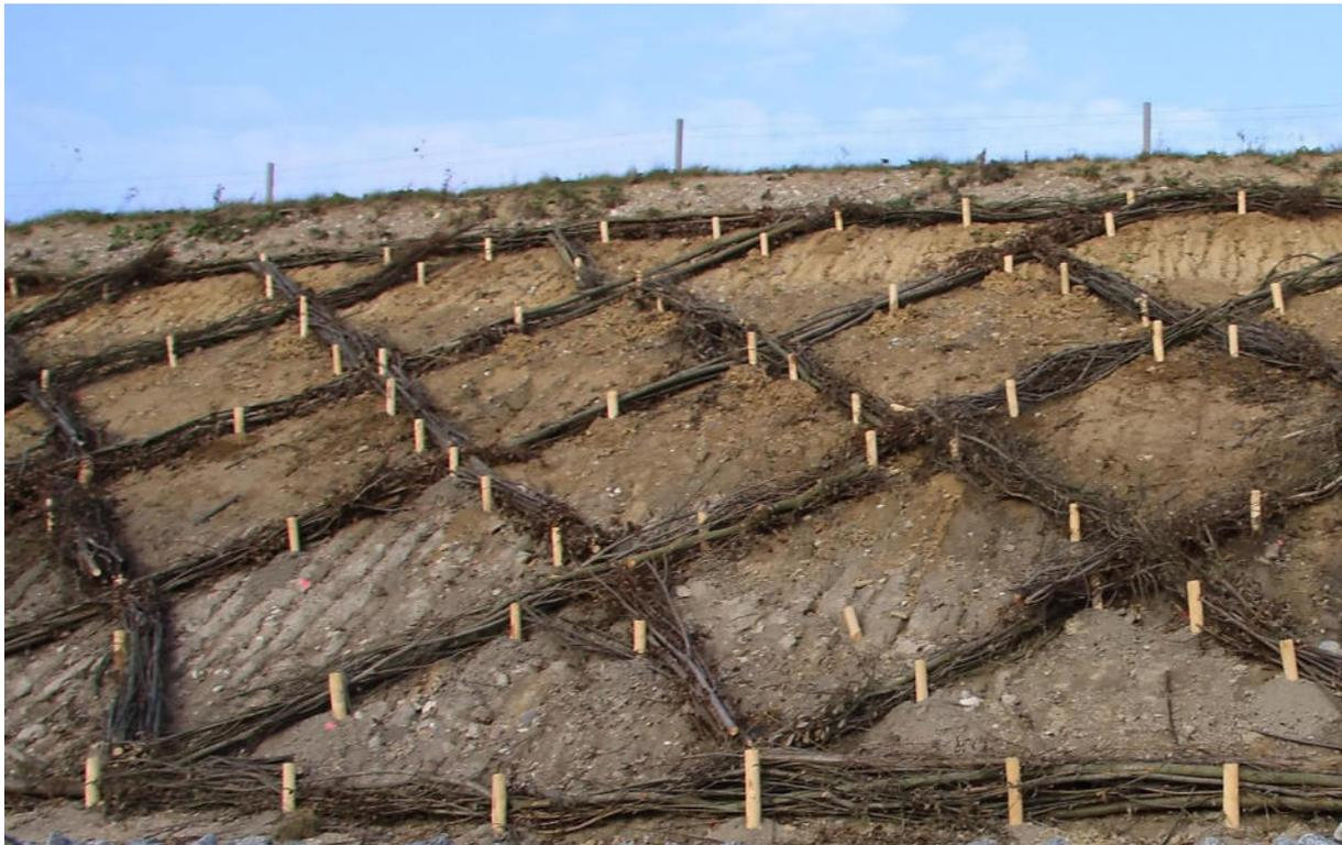
*Bild 6.10 Böschungssicherung mit Faschinen an der BAB 20 (Foto: H. Saathoff)*
