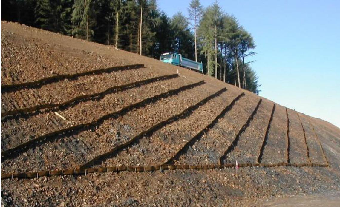
*Bild 6.8 Fixierung einer Oberbodenschicht auf einer steilen Böschung, Beispiel für Böschungsbänder (Foto: Neisser Geoprodukte GmbH)*
