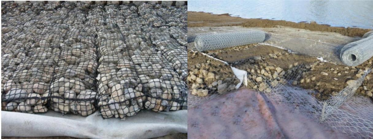
Bild 3.8 Steinmatratzen mit Textilnetz (links, Foto: S. Wiese) und Drahtnetz (rechts, Foto: R. Neisser)
