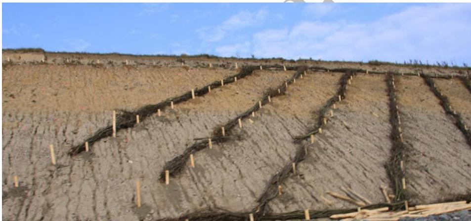
*Bild 6.11 Böschungssicherung mit Faschinen an der BAB 20, Bauzustand (Foto: H. Saathoff)*
