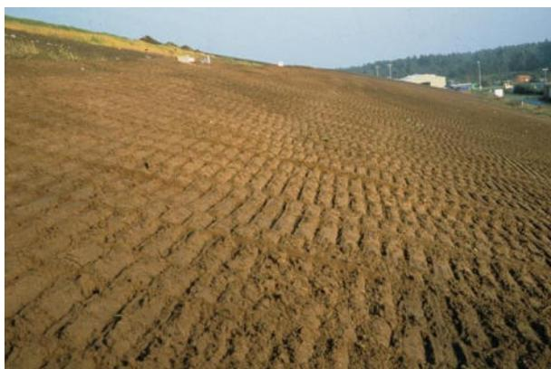
*Bild 5.2 Raue Böschungsoberfläche der Deponie Bardowick im Jahr 2000, durch Raupenketten hergestellt, nur für Böschungsneigungen bis 1:2 (Foto: E. Stalljann)*
