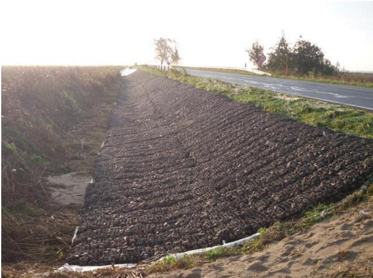
*Bild 6.26: Erosionsschutz mit Steinmatratzen an einer Grabenböschung als Hochwasserschutz (Foto: S. Wiese)*
