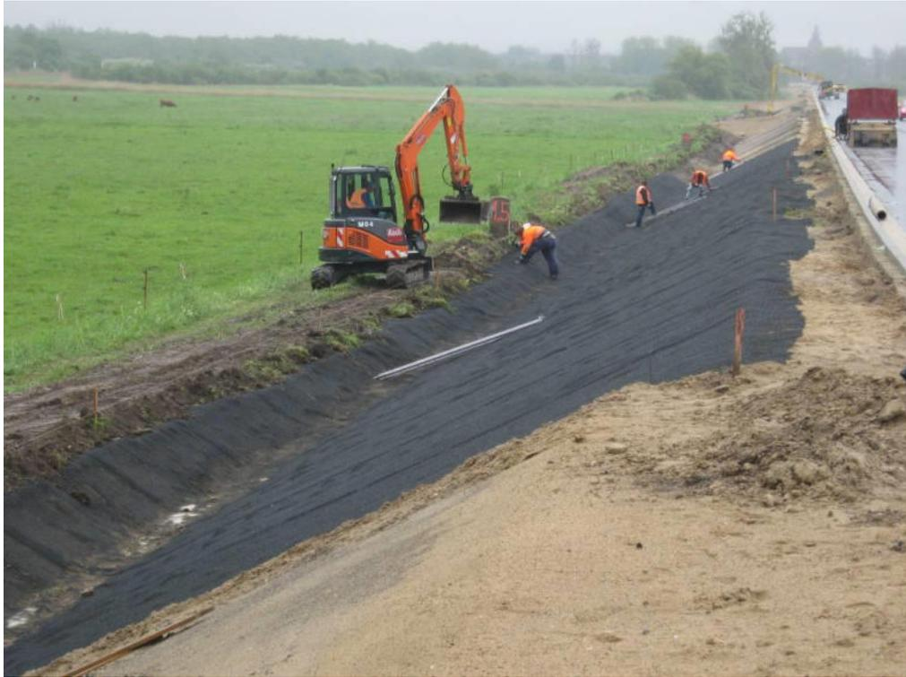
*Bild FB6.1: Bauzustand Einbau GMA (Foto: Colbond GmbH & Co. KG)*
