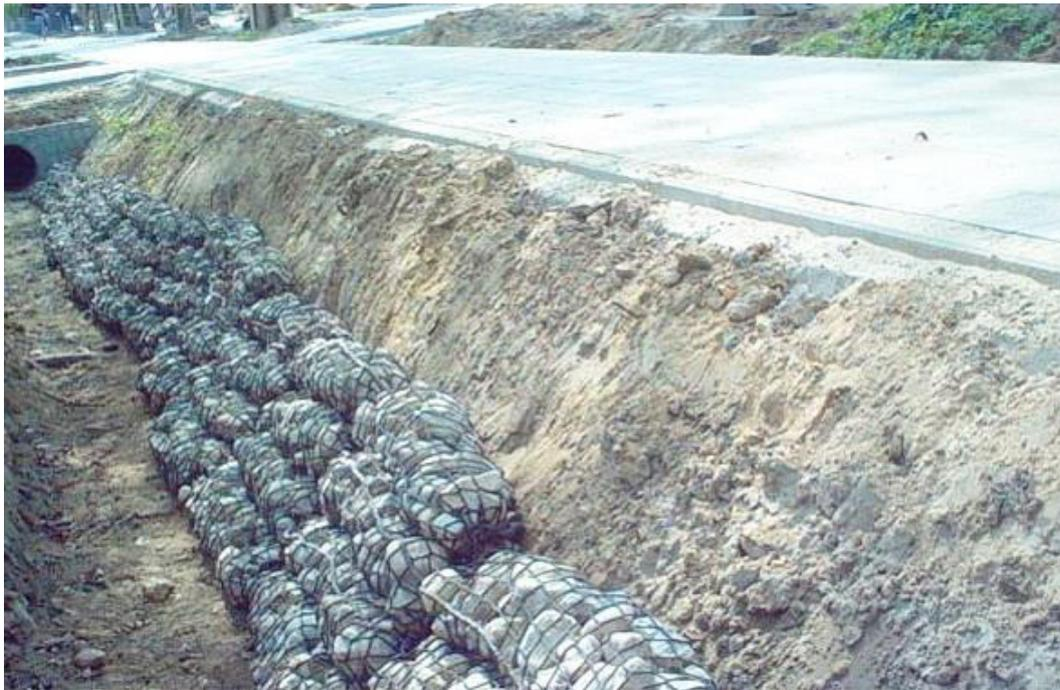
*Bild 6.24: Steinwalzen zum Schutz des Sohlbereichs (Böschungsfuß) eines Entwässerungsgrabens mit sehr steiler Böschung im Bereich von Durchlässen (Foto: S. Wiese)*
