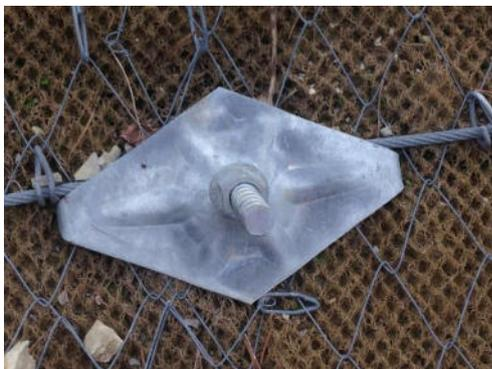
*Bild 6.5 Erosionsschutz an felsiger Anschnittböschung, Beispiel für GMA, Detail Befestigung (Foto: F. Saathoff)*
