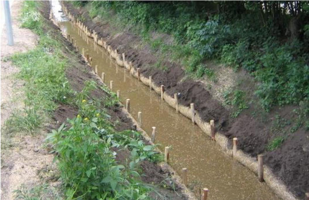
*Bild 6.22: Erosionsschutz mit Walze am Böschungsfuß – Beispiel Straßengraben (Foto: S. Wiese)*
