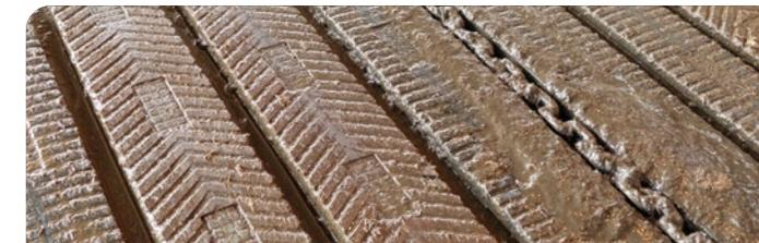
Abbildung 4: modifizierter fischgrätenartiger Relieffußboden
