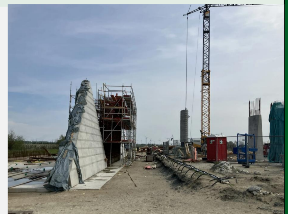
A 26 West - 24.04.2025 - Bauwerk 14 Fledermaus-querung über A26 Flügel Nord; Bild: DEGES
