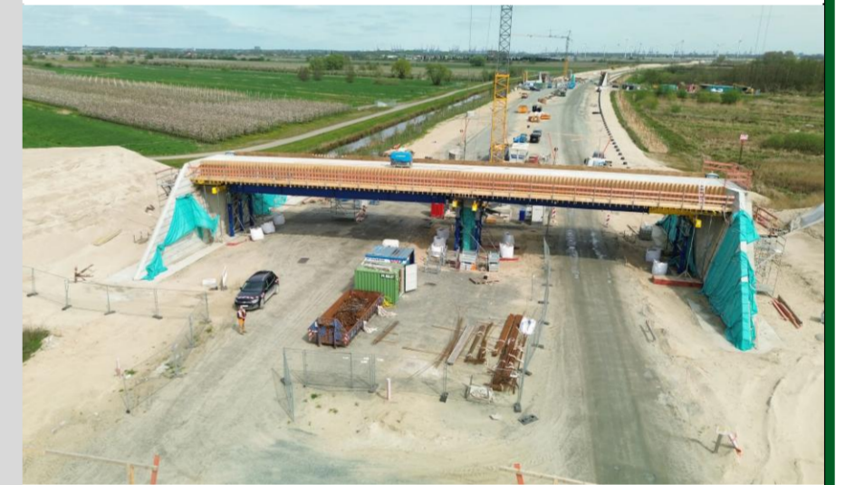
A 26 West - 24.04.2025 - Bauwerk 28, Neuenfelder-Hinterdeich; Bild: DEGES
