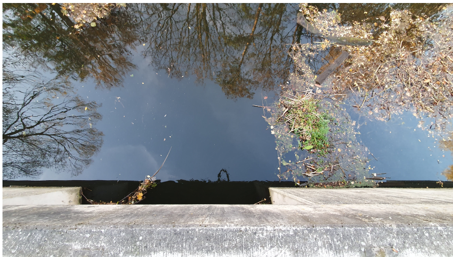
Abbildung 5.4: Bleicherwehr am 02.11.2024 während eines Überschreitungsereignisses
